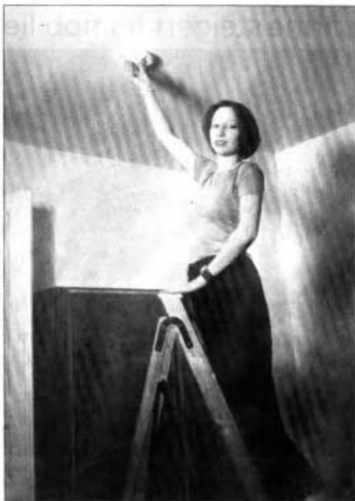
Die Montage eines Rauchmelders sollte möglichst in Raummitteln an der Zimmerdecke erfolgen.
